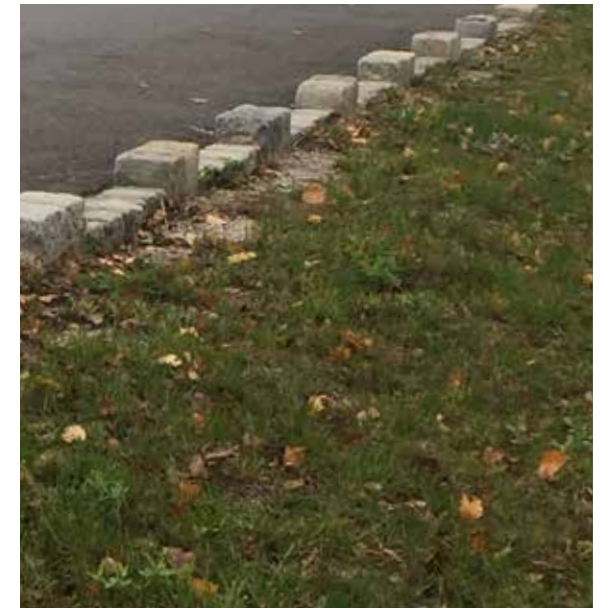
Einleitung durch niveaugleich eingesetzte Pflastersteingruppen
