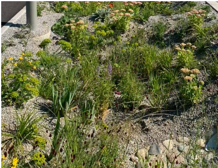
Sickermulde mit Stauden und Gehölzen, Alte Poststraße, Graz
