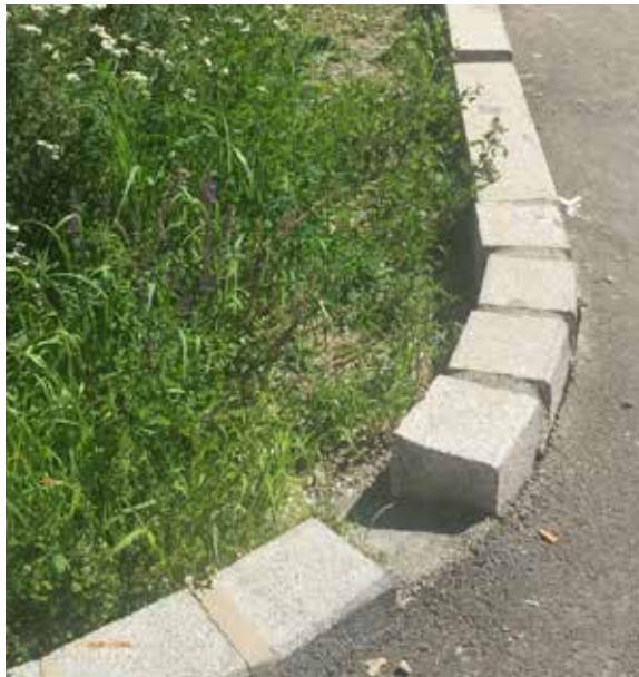
Einleitung durch punktuelle Öffnung des Bordsteins
