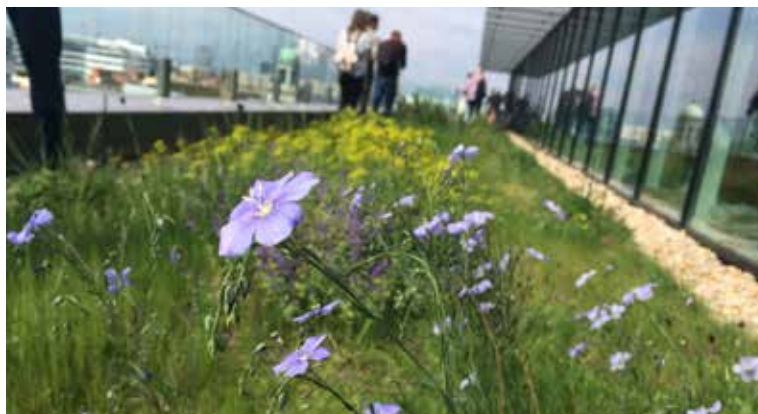
Semi-intensive Dachbegrünung in Graz
