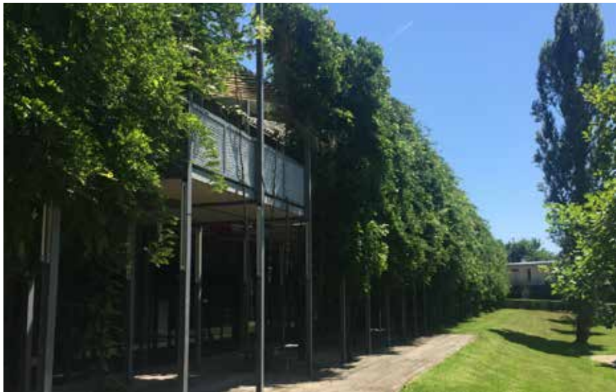
Bodengebundene Fassadenbegrünung in Lang, Steiermark
